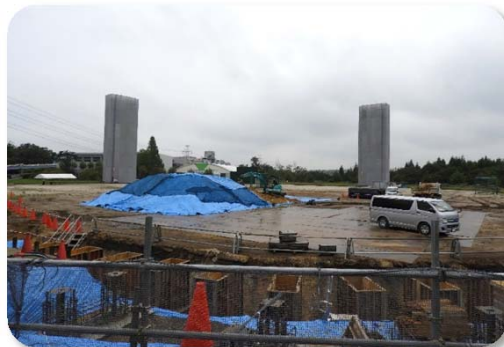
軟式野球場改修工事現場
